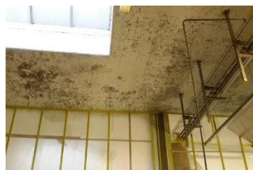
Bild 2 (Halle XY, hinterere Bereich)
